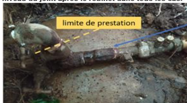
3- Pour le cas des niches dans lesquelles des dispositifs de dérivation vers un robinet de jardin ou autre ont été réalisés, le syndicat interviendra sur le té de raccordement et le cas échéant sur le robinet d'arrêt et le coude, mais pas sur la tuyauterie située après le coude. La limite de responsabilité se situera au niveau du joint après le robinet dans tous les cas.
